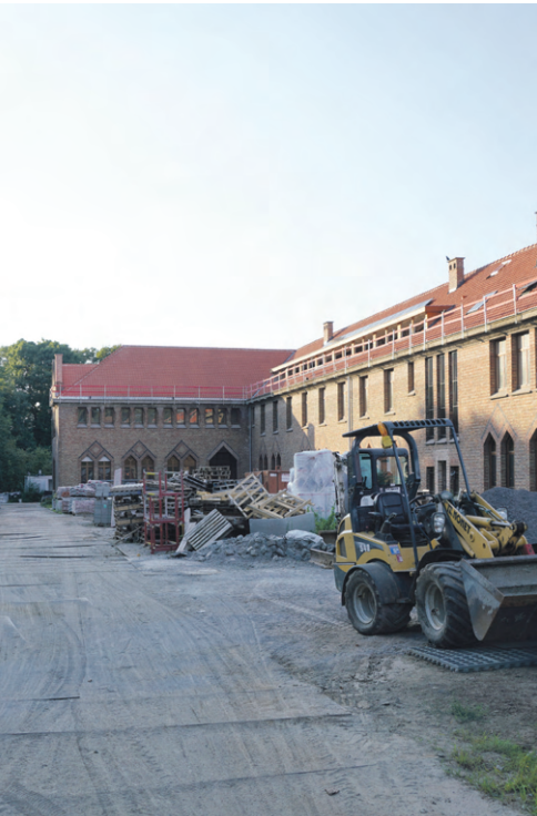
Oud klooster van de Visitatie wordt verbouwd
