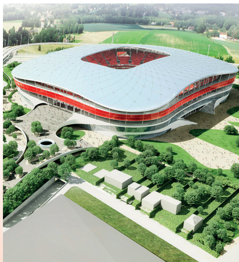
Voldoet dit stadion aan het MER en GRUP? (foto: Ghelamco)
