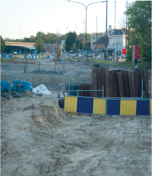
Geen beweging meer in de heraanleg van de Woluwelaan
